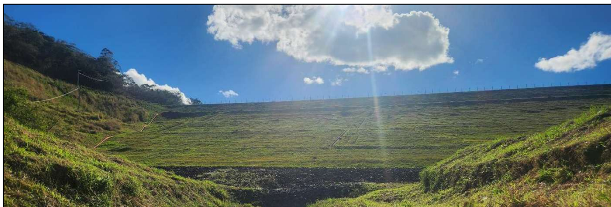
Figura 22.3 – Taludes de jusante da Barragem Rancho Casca
