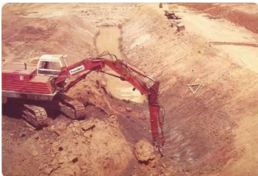
Figura 6.1 - Escavação da trincheira drenante (10/3/86)
