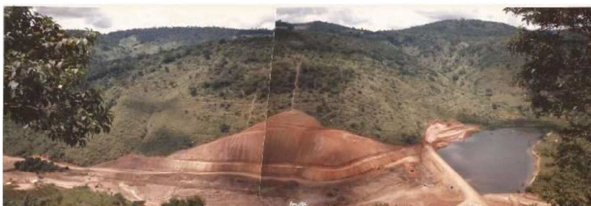
Figura 5.2 - Vista panorâmica da área de implantação da barragem Rancho Casca, vendo-se à esquerda, no canto inferior, parte da central de britagem; em frente, a ombreira direita, destacando-se o canal de desvio; à direita a ensacadeira e parte da bacia de acumulação
