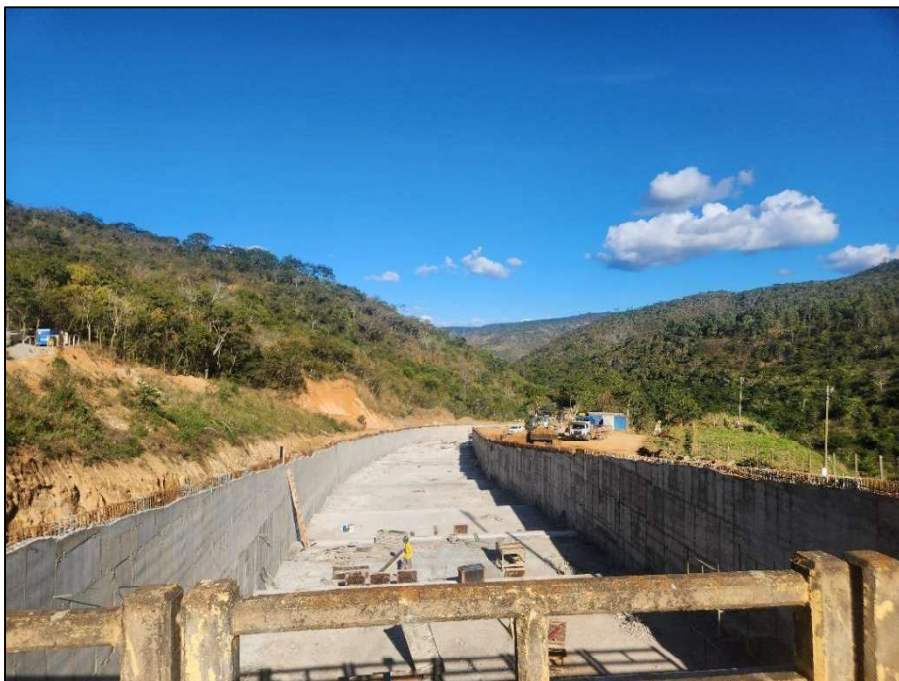
Figura 6.6 - Canal extravasor em escadaria hidráulica
