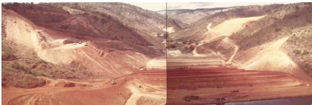
Figura 5.3 - À esquerda o vertedouro, em execução; à direita a ombreira
