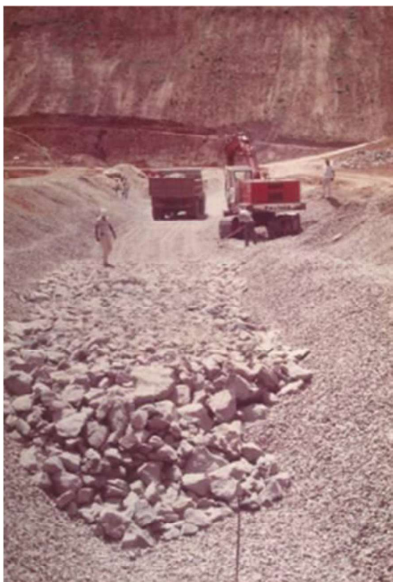
Figura 6.3 - Detalhe da execução da trincheira drenante (14/4/86)
