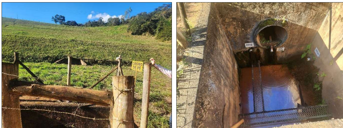
Figura 22.8 – Vista do dreno de fundo da Barragem Marçu
