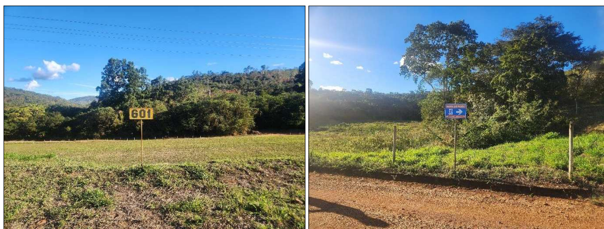
Figura 22.6 – Sinalização e cercamento na Barragem Marçu
