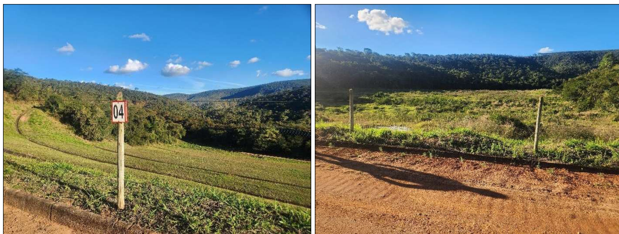
Figura 22.7 – Sinalização e cercamento na Barragem Marçu
