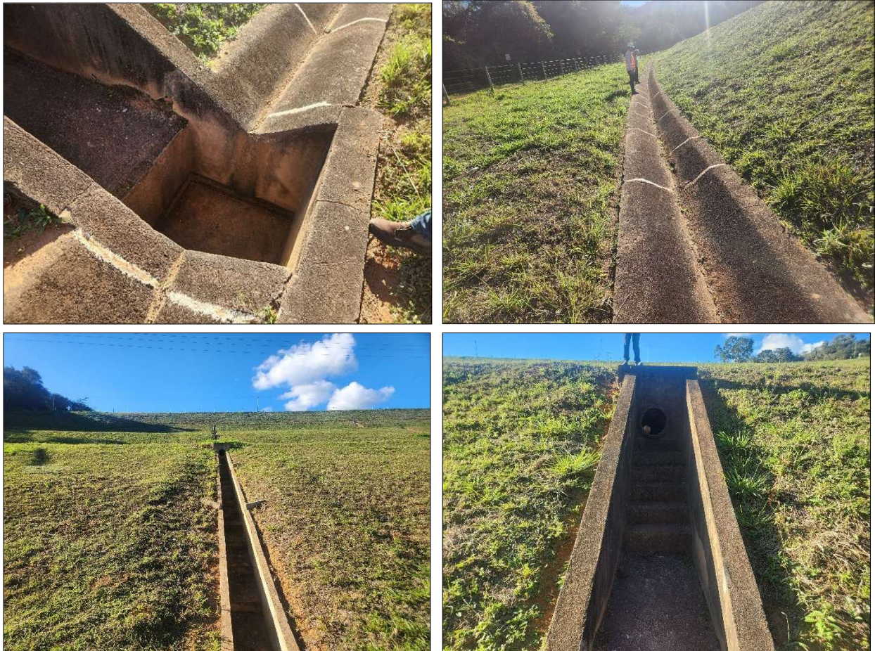
Figura 22.9 – Sistema de drenagem superficial observado durante visita técnica
