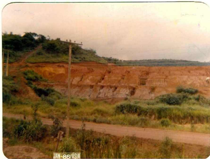
Figura 5.2 – Vista de jusante da ombreira direita, antes do início da implantação do último alteamento, exibindo o perfil de solo característico do local (Fonte: Planilha de Evolução de Custos por Item)
