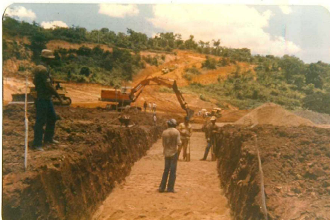
Figura 6.2 – Foto da construção da drenagem interna da Barragem Marçu (15/12/1985)
