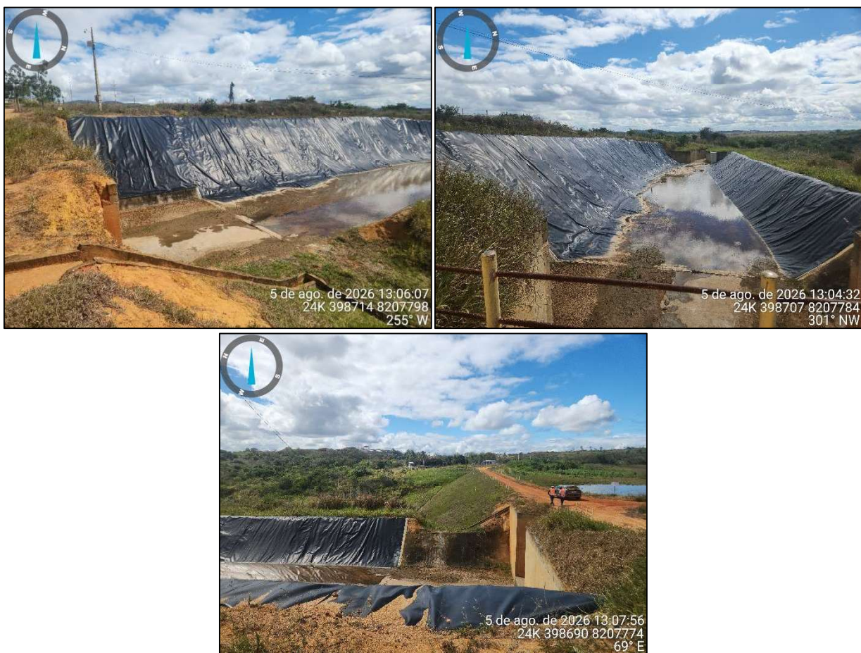
Figura 22.5 – Situação do canal extravasor da Barragem Califórnia
