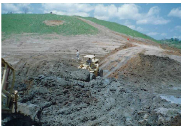
Figura 5.3 – Limpeza do terreno de fundação e na várzea (1ª etapa)
