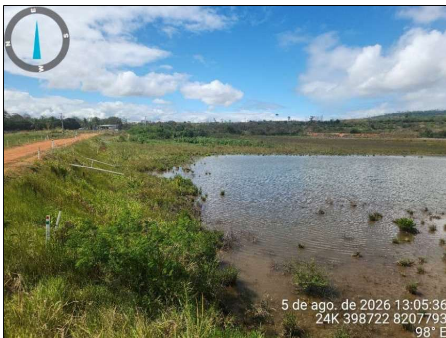
Figura 22.3 – Talude de montante da Barragem Califórnia
