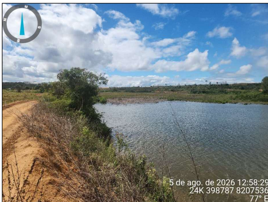
Figura 22.2 – Reservatório da Barragem Califórnia
