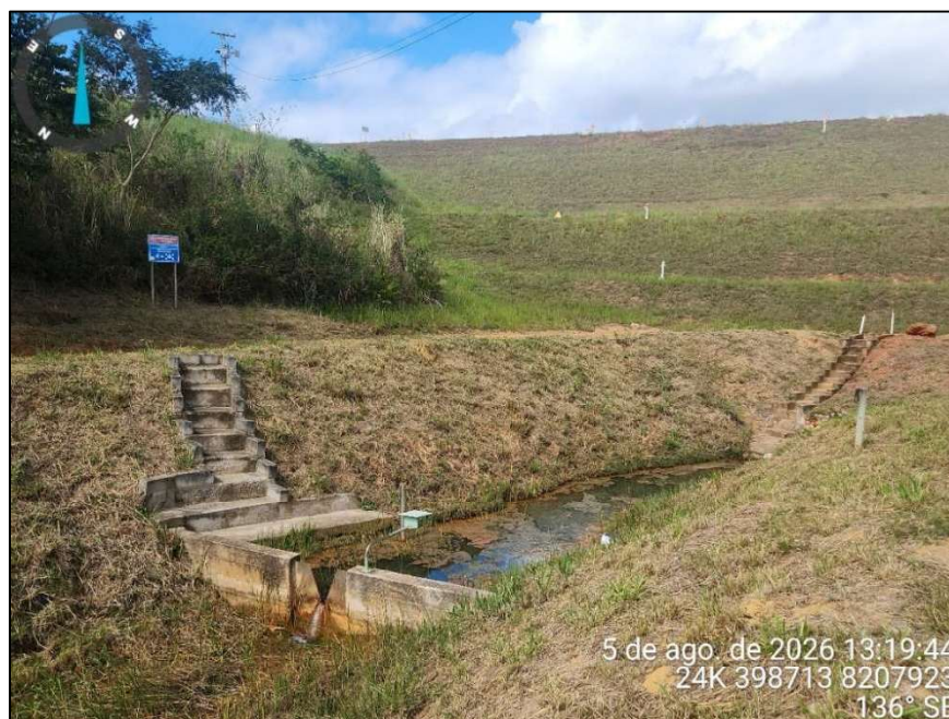
Figura 22.6 – Vista da saída do dreno de fundo da Barragem Califórnia
