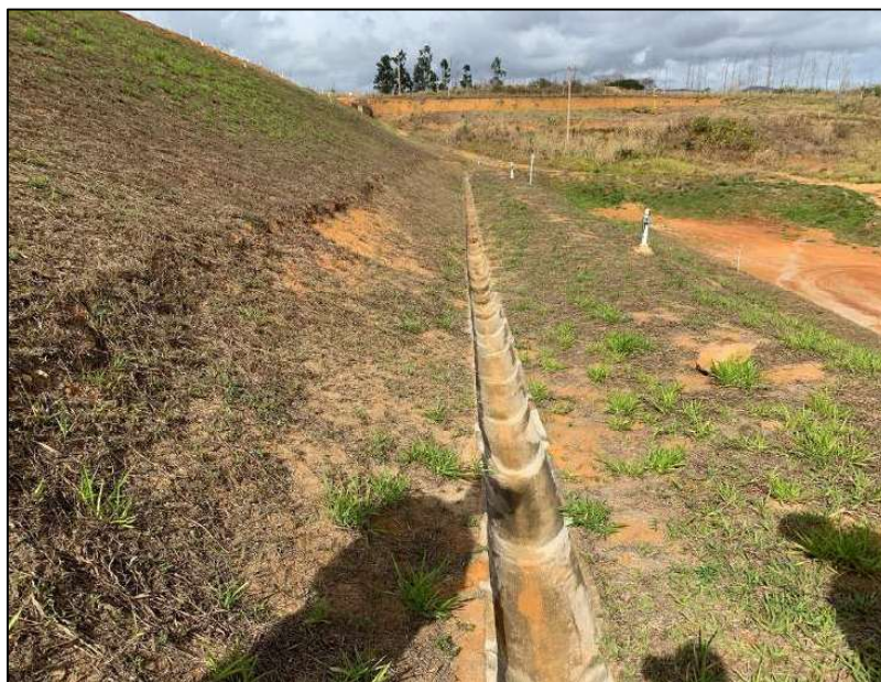
Figura 10.8 - Vista da canaleta de drenagem
