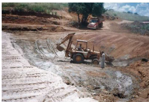
Figura 5.4 – Limpeza concluída e tapete de areia sobre o terreno da fundação (1ª etapa)
