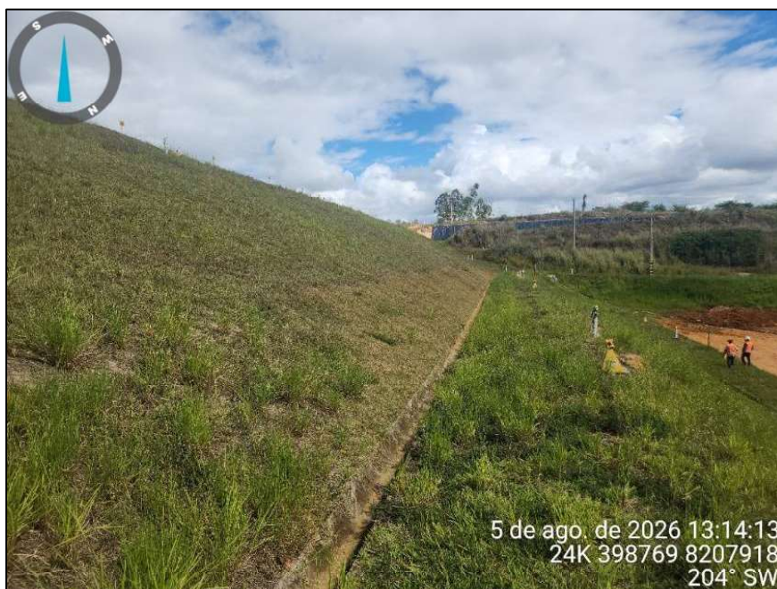
Figura 22.4 – Talude de jusante da Barragem Califórnia
