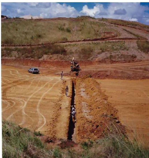
Figura 6.5– Filtro vertical em execução (1ª etapa)
