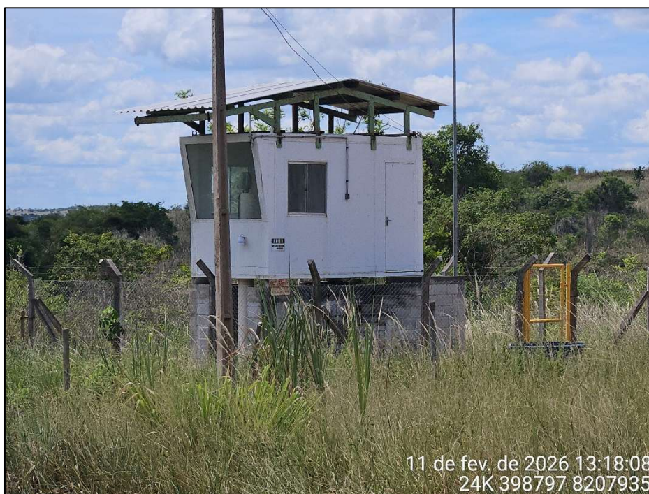
Figura 14.2 - Cabine de instrumentação para leitura automatizada dos marcos superficiais
