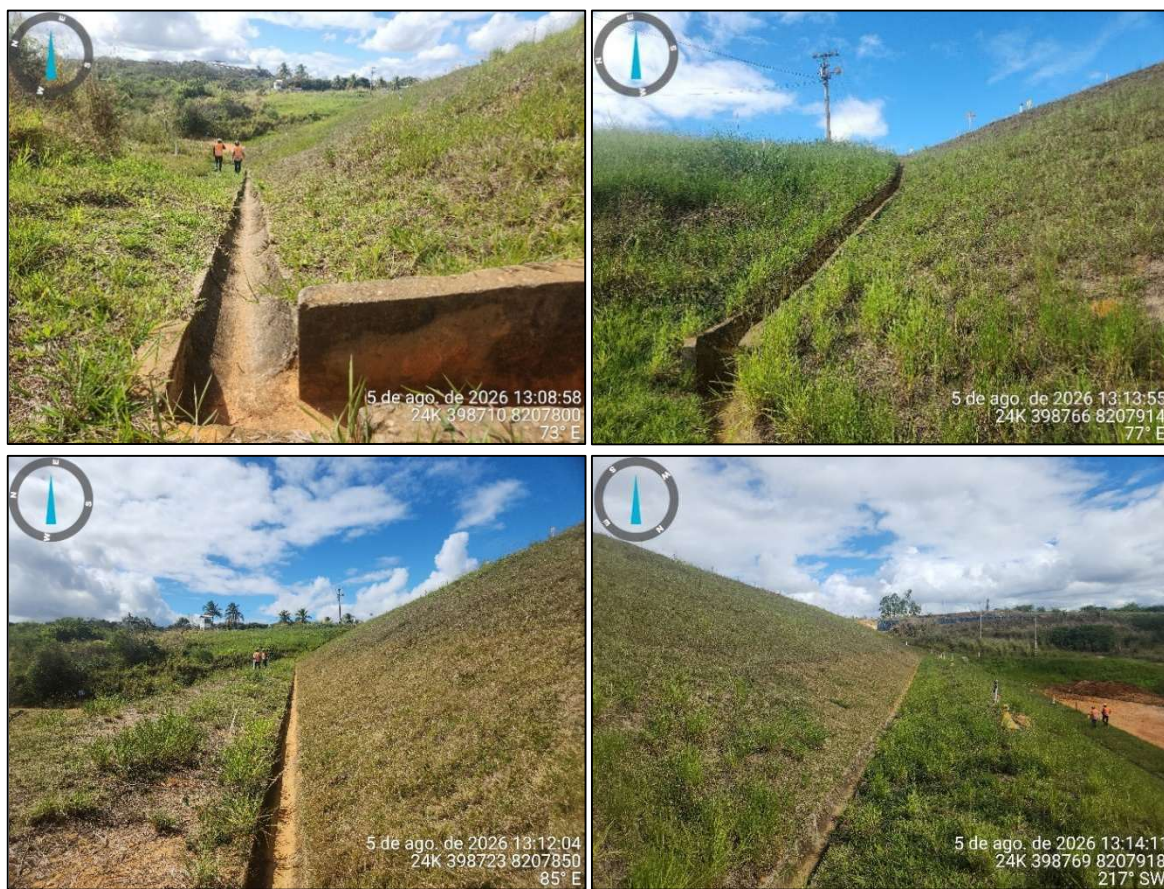
Figura 22.7 – Situação dos dispositivos de drenagem superficial da Barragem Califórnia
