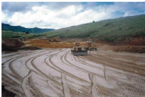
Figura 6.2– Tapete de areia sobre a fundação (1ª etapa)
