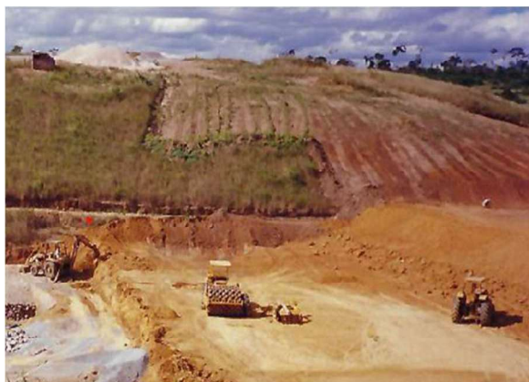
Figura 5.1 – Limpeza na fundação e ombreira direita (1ª etapa)
