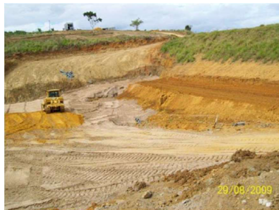
Figura 5.2 – Limpeza na fundação e ombreira esquerda (2ª etapa)
