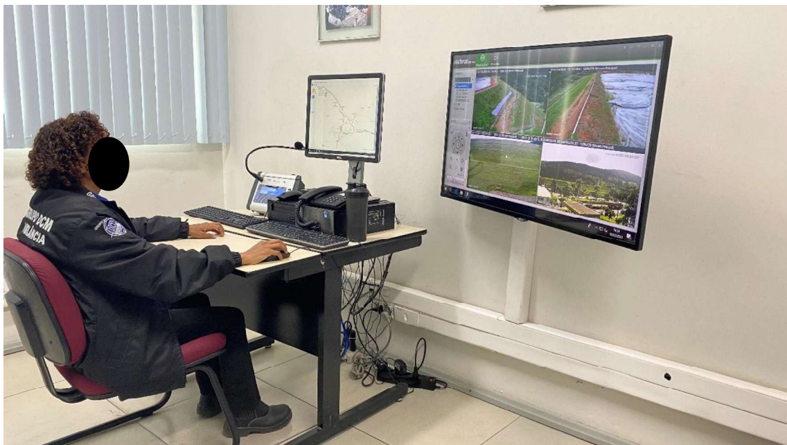
Figura 12.1 – Foto da sala de monitoramento e controle da barragem
