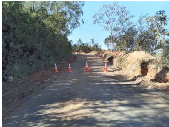
Figura 17.4 – Exercício de treinamento prático interno ciclo 2021-2022. A: Deslocamento da população na ZAS para o ponto de encontro. B: Placa sinalizando a rota de fuga programada para a segurança do ponto de encontro. C e D: Pontos de encontros distintos com recebimento de pessoas do treinamento. Os locais são sinalizados, espaçosos e estão em boas condições de conservação. E: Bloqueio de via de acesso próximo à ETEQ para evitar acesso de transeuntes em área de risco
